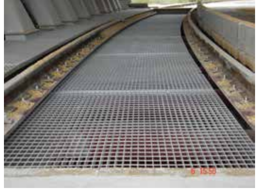
Pesatura in curva con pianale in grigliato
