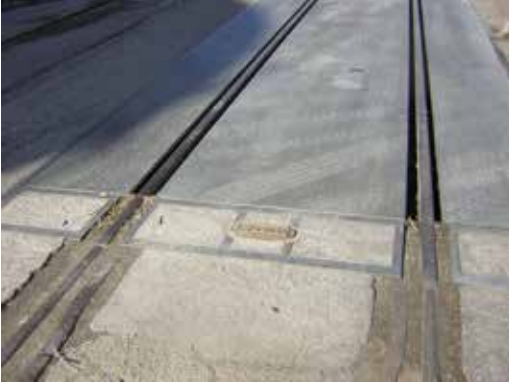
Pesa a ponte doppio uso per wagons e automezzi
